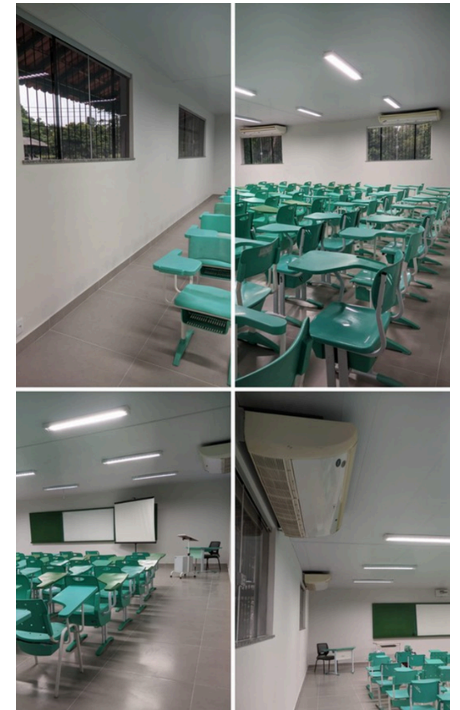
MANUTENÇÃO PREDIAL DA SALA DE AULA DO PRÉDIO DE ZOOTECNIABÁSICA
