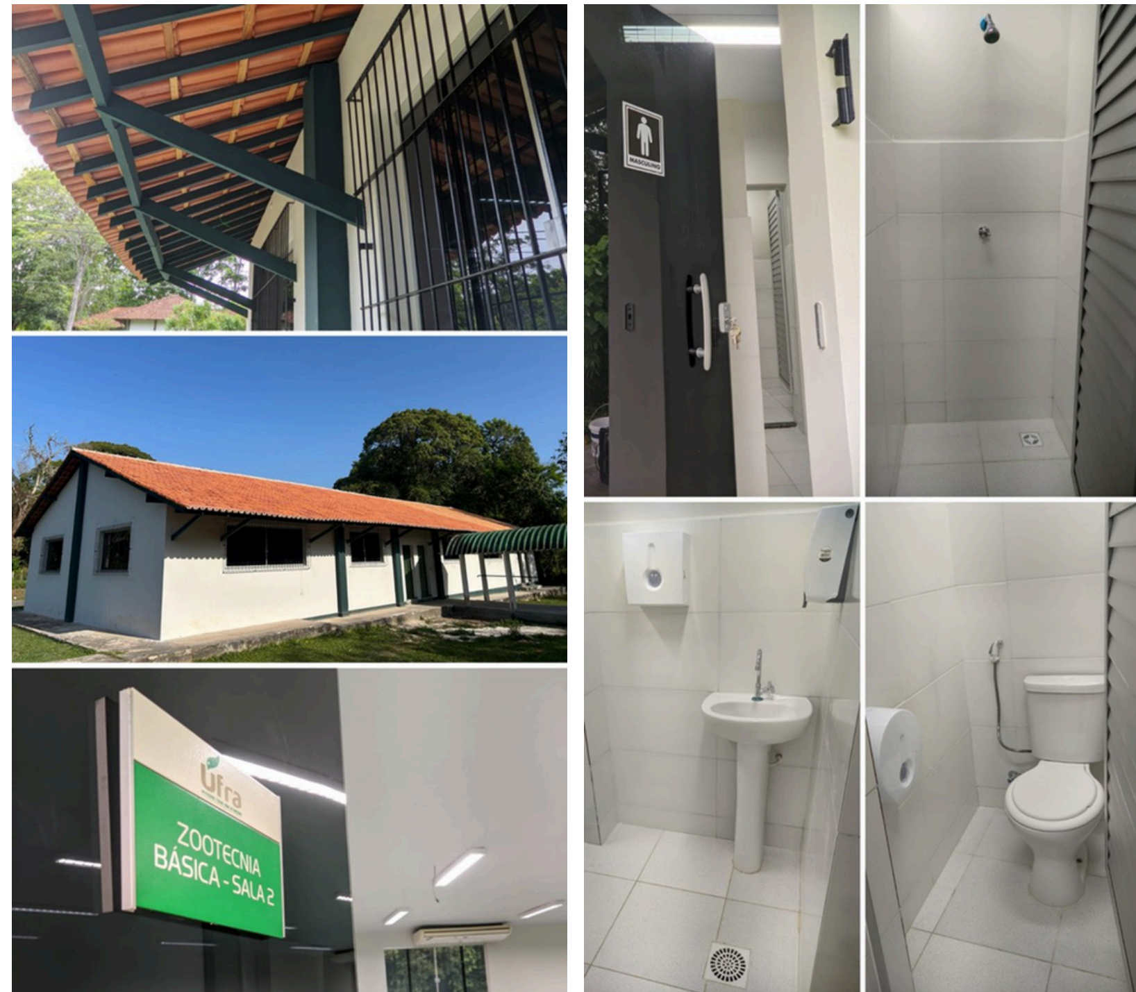
MANUTENÇÃO DO PRÉDIO DE ZOOTECNIABÁSICA
